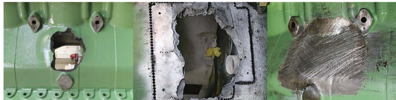
Ремонт оборудования методом «Металок»
